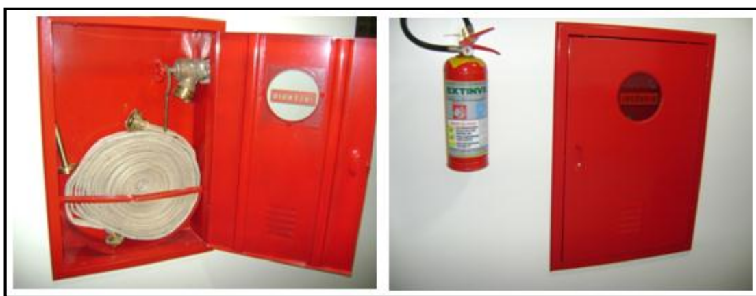
Figura 42 – Hidrante Fonte: Arquivo pessoal
