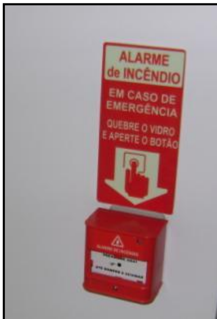
Figura 33 – Botoeira do tipo quebra vidro existente no edifício Fonte: Arquivo pessoal
