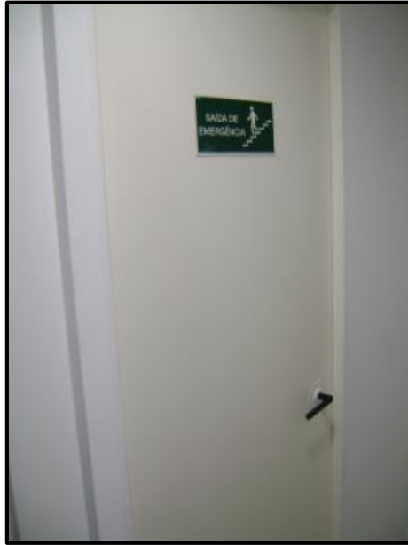
Figura 31 – Porta corta-fogo da escada enclausurada e detalhe da maçaneta Fonte: Arquivo pessoal
