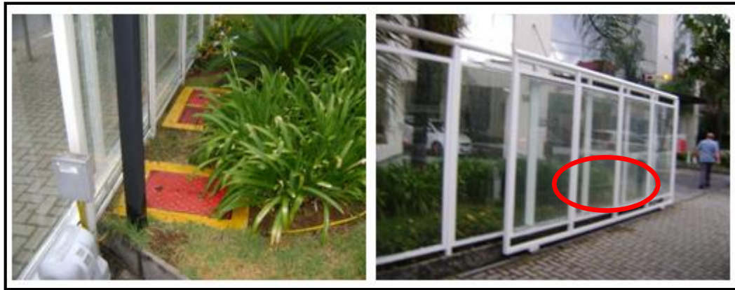
Figura 43 – Válvula de recalque e parede de vidro obstruindo a válvula Fonte: Arquivo pessoal
