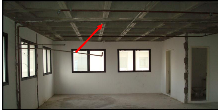
Figura 28 – Laje nervurada existente no edifício Fonte: Arquivo pessoal
