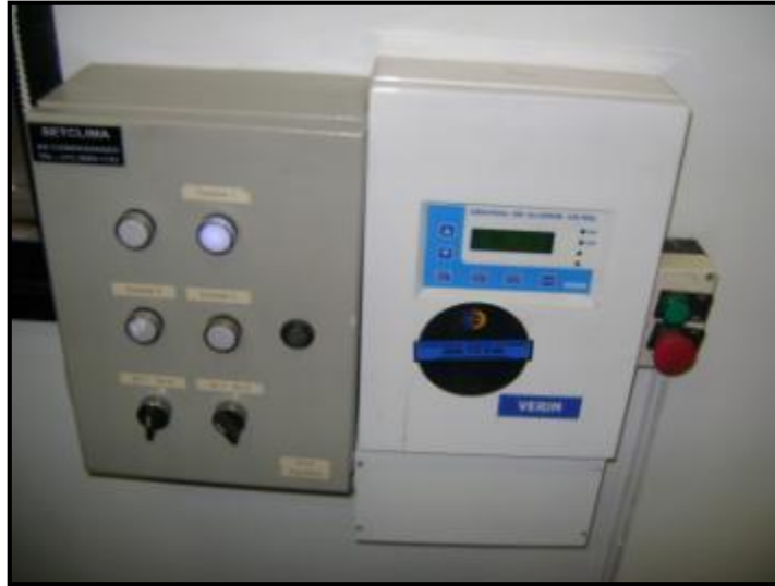
Figura 36 – Sistema de controle de exaustão e central de alarme Fonte: Arquivo pessoal
