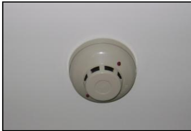
Figura 35 – Detector de fumaça existente no edifício Fonte: Arquivo pessoal
